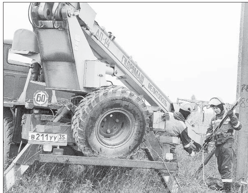
Бригада РЭС устраняет повреждение на электролинии возле деревни Рогачиха.
