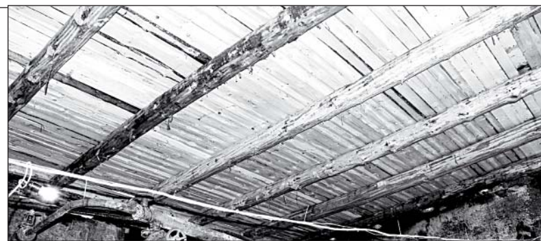
Кровля котельной отремонтирована силами добровольцев при помощи местных предпринимателей
