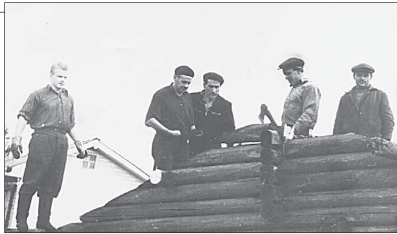
Заканчивается строительство дома в д. Задорино, первый слева Иван Медведников
