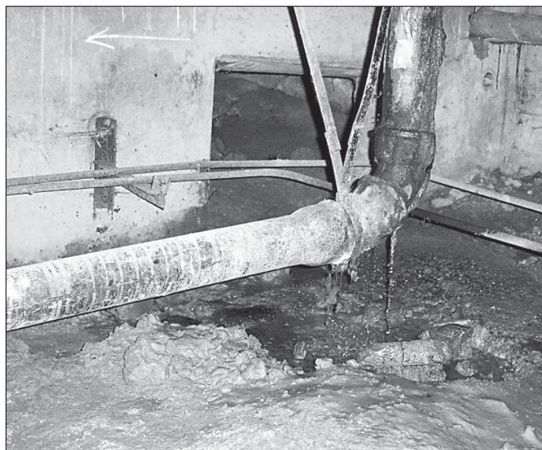
В доме №27 по улице Пионерской запланирован капитальный ремонт инженерных сетей в подвальном помещении
