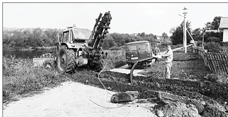
Прокладка газопровода по улице Титова.
