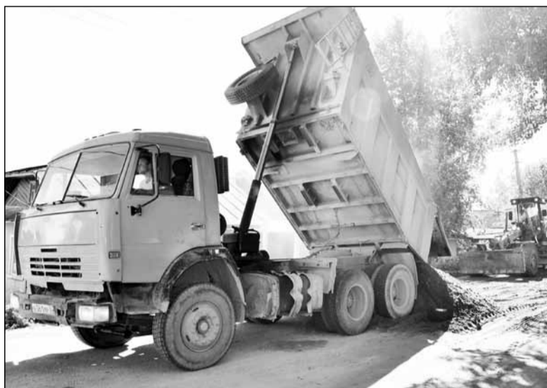
Идет подсыпка улицы Стебенева
