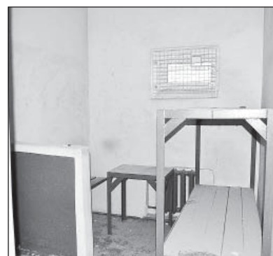
Ремонт в камерах продолжается.
