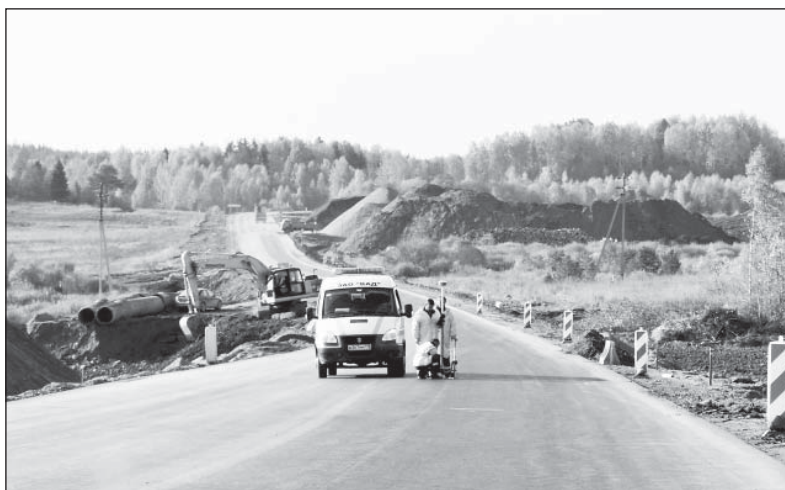
Вместе с верховажскими дорожниками трассу М8 отремонтировала и компания «ВАД» из Санкт-Петербурга
