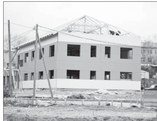
У Дома культуры ведет строительство ИП Г. Бабакишиев
