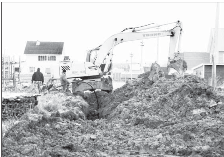
Прокладка водопровода по улице Рябиновой в д. Сомицыно
