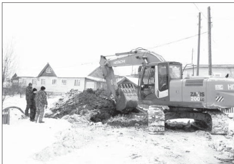
Водопровод (2012 год) – направление на поселок Прибрежный
