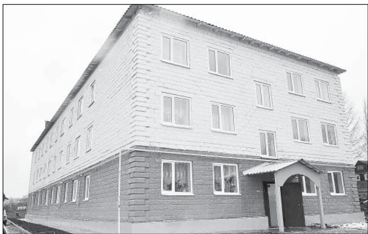
Новый дом для переселенцев из ветхого и аварийного жилья на Кошеве.
