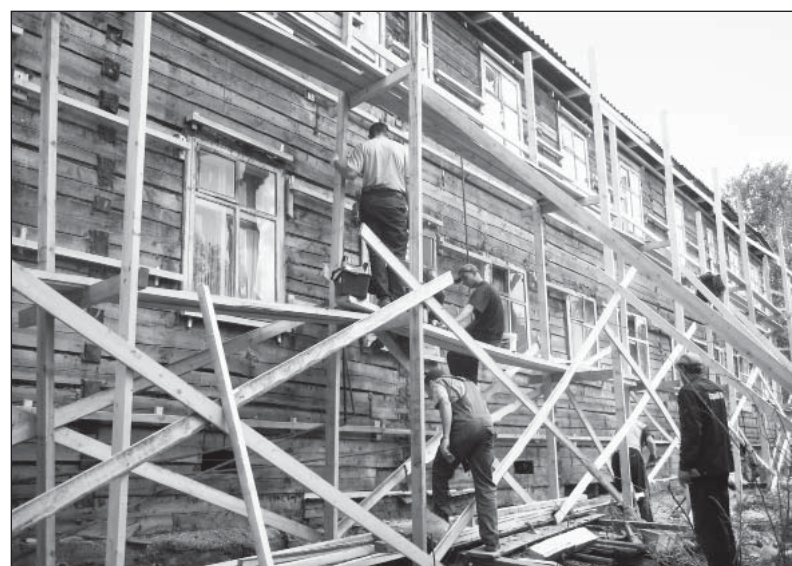
Капитальный ремонт жилого дома на улице Полевой, 2010 год. Фото из архива редакции
